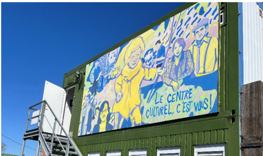
Photo de la structure du CCPC située à Frasnes-lez-Anvaing.
